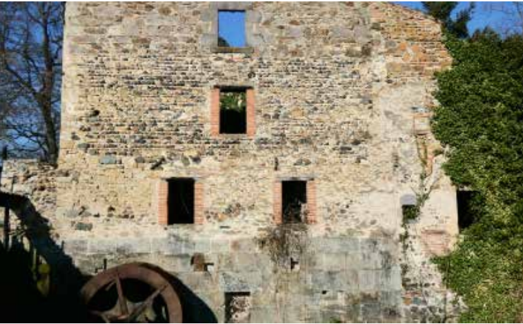
Figure 1 façade Est du moulin, en bas les meulières sans joints en granit puis les pierres de Gevillat et Nonette, puis quelques vestiges du début XVIII e , les litages de galets en plein XVIII e , et les granits XIX e
