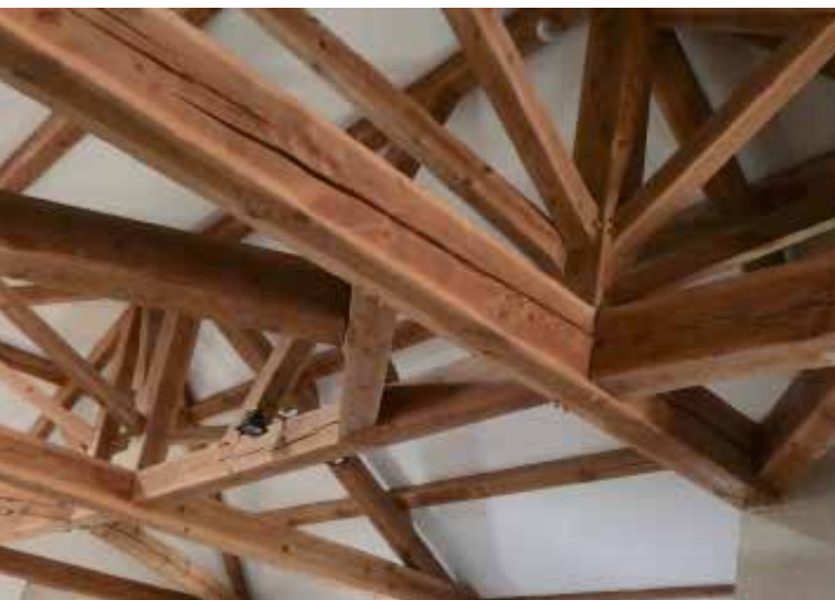
Figure 3 Charpente neuve de l'aile Sud, remarquer les poinçons, contre-fiches et enrayures massives.
