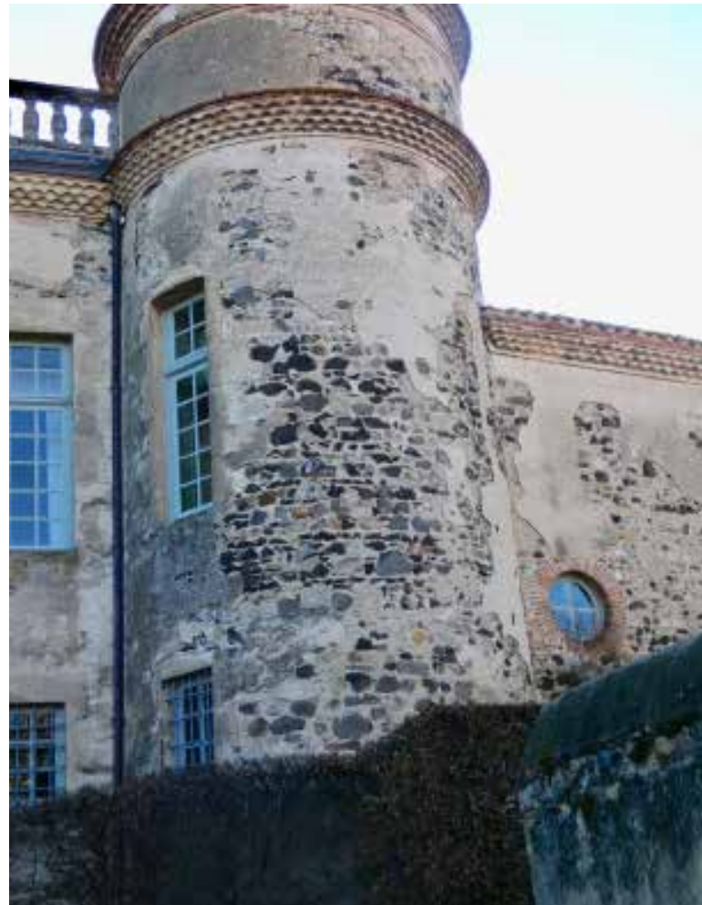
Figure 2 Tour Sud-Ouest construite par François II, l'absence de crépi nous montre la diversité des matériaux à dominance de basalte provenant de la récupération sur place et d'Usson.
